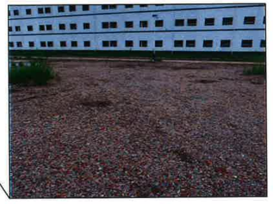
碎石铺装0.40hm 2
